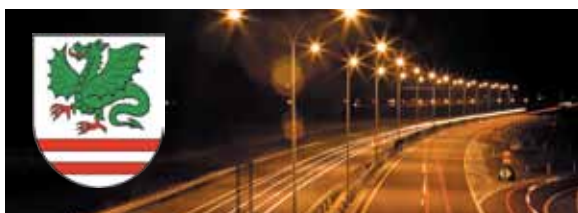
Obwodnica Garwolina - fragment modernizowanej drogi ekspresowej dwupasmowej S17 Lublin -Warszawa. Bypass of Garwolin - part modernized two-lane express road S17 Lublin - Warsaw.
